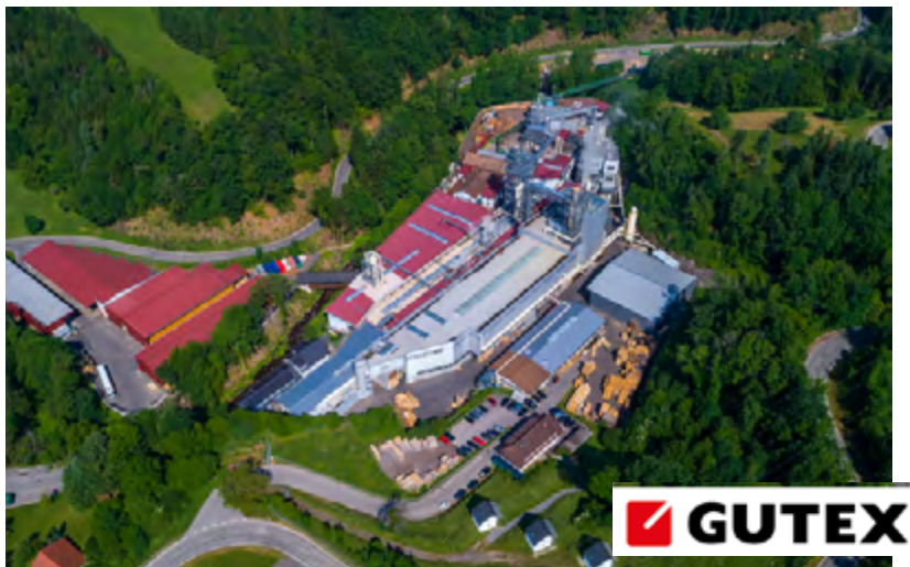
Abb. 10: Luftbild des Firmengeländes von GUTEX © GUTEX
