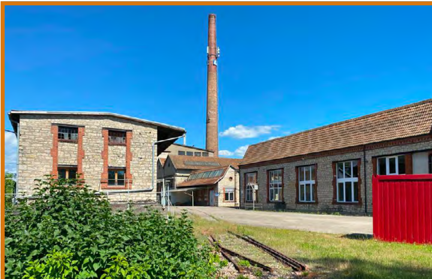
Abb. 07: Ansicht der Bestandsgebäude, die erhalten bleiben © Stadt Lörrach
