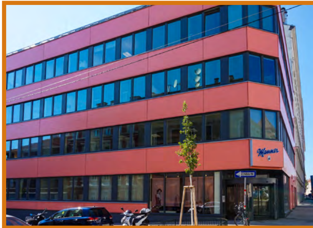
Abb. 21: Hauptgebäude mit vertikaler Produktion der Joseph Manner & Comp AG in Wien © Kerstin Meyer
