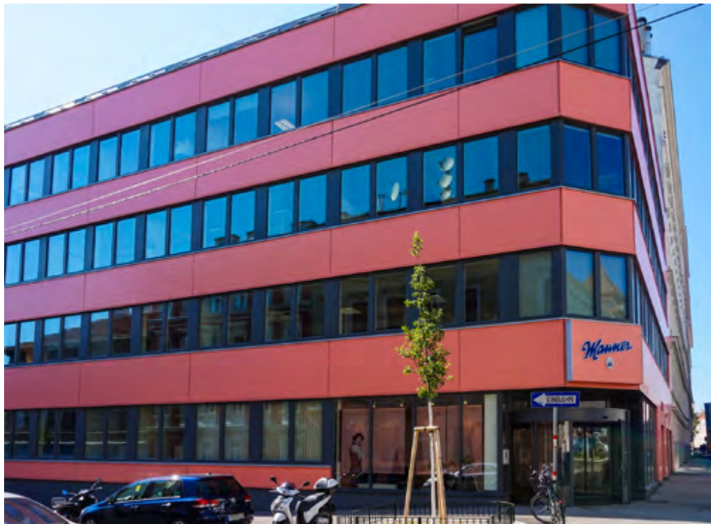
Abb. 14: Hauptgebäude mit vertikaler Produktion der Joseph Manner & Comp AG in Wien © Kerstin Meyer
