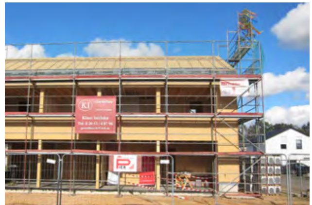
Abb. 30/31: Das Gebäude der Faktor X-Agentur ist bis auf die Bodenplatte ein Holzbau.
