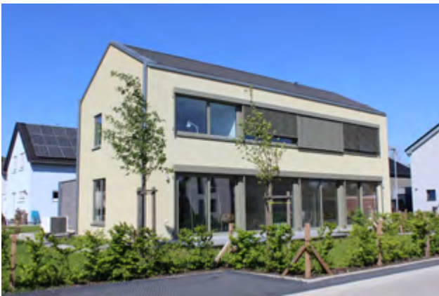
Abb. 30/31: Das Gebäude der Faktor X-Agentur ist bis auf die Bodenplatte ein Holzbau.
